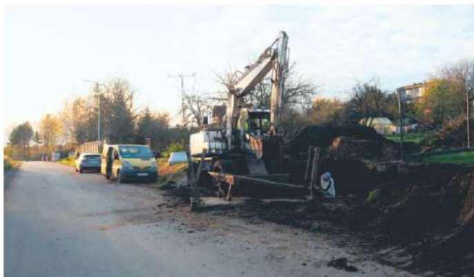
Budowa kanalizacji sanitarnej w ul. Brzechwy w Chełmku
