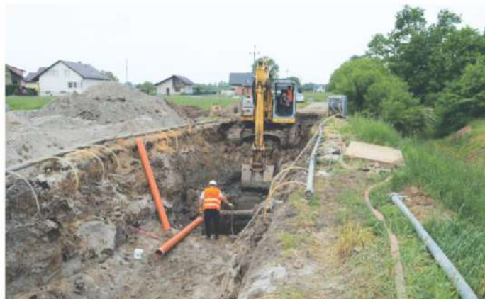
Budowa kanalizacji w ul. Kolistej w Bobrku
