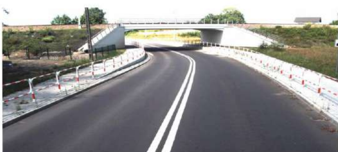
Wiadukt w ciągu ul. Oświęcimskiej w Gorzowie
