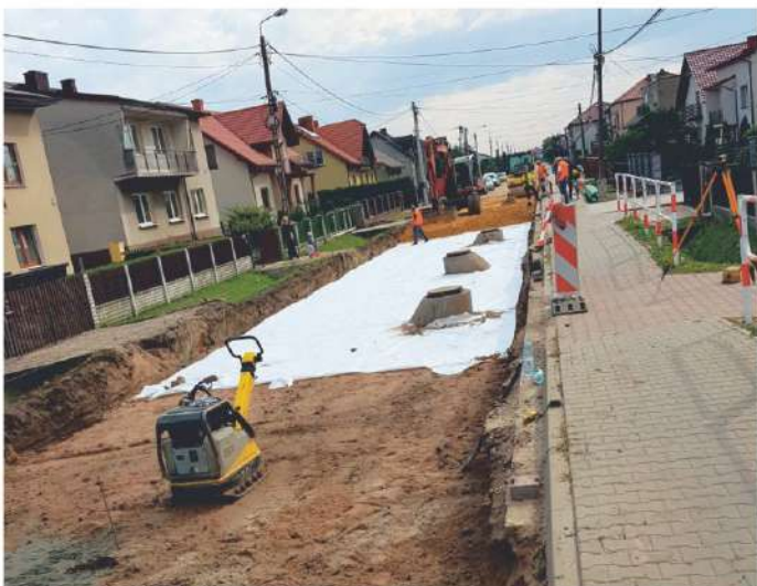
Budowa kanalizacji w ul. Nadwiślańskiej w Bobrku
