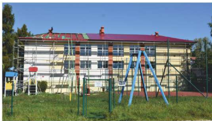
Modernizacja dachu na budynku sali gimnastycznej SZS nr 1 w Chełmku.
