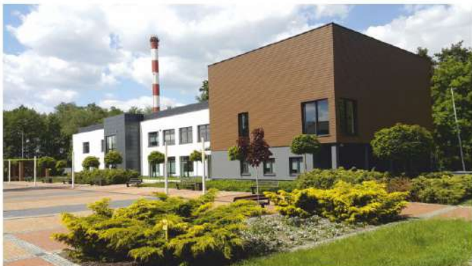
Budynek biblioteki po zakończeniu robót
