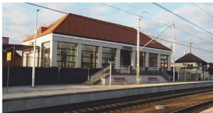
i po przebudowie
