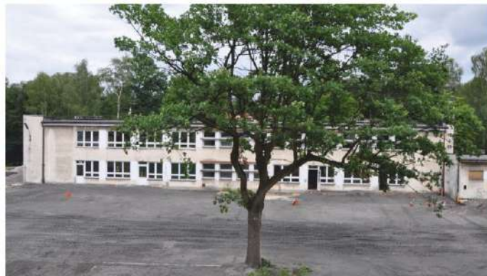
Budynek byłego przedszkola przed ...
