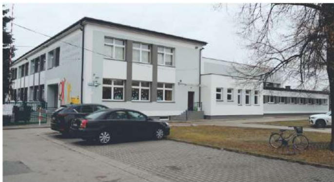
Przebudowany budynek Samorządowego Zespołu Szkół w Gorzowie
