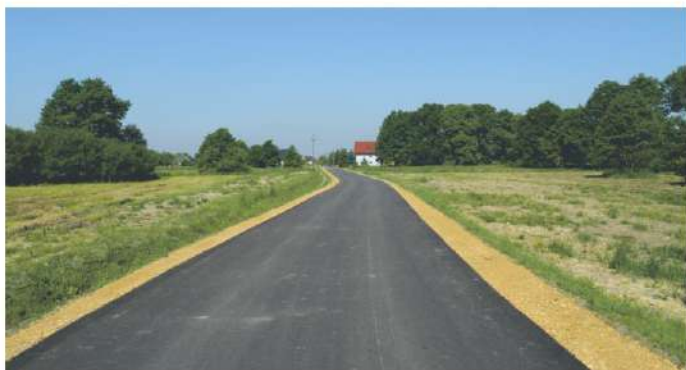
Nowo wybudowany odcinek ul. Cichej w Bobrku
