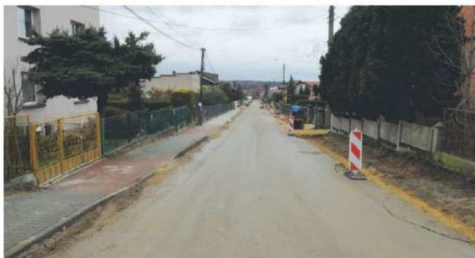
Remont ul. Słowackiego w Chełmku
