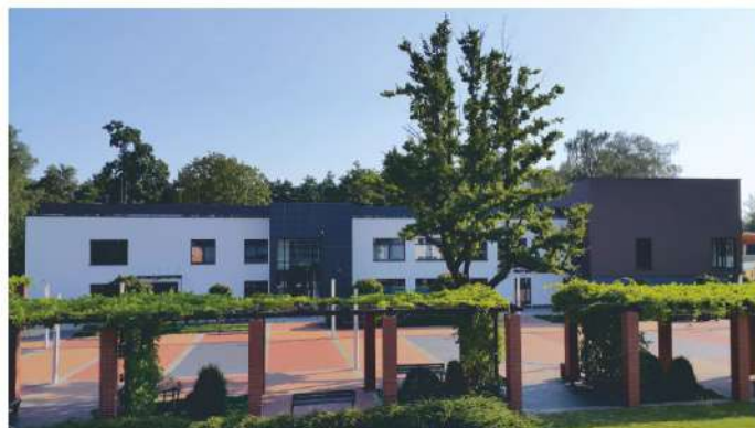
i po przebudowie
