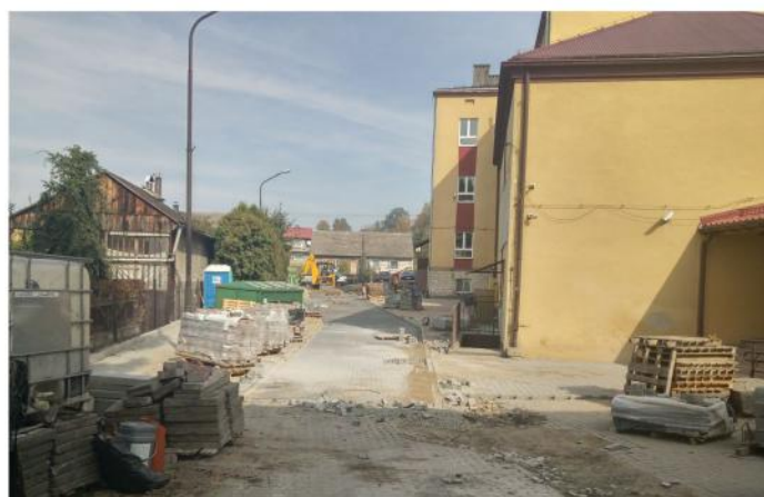
Budowa kanalizacji i miejsc postojowych przy SZS nr 1.
